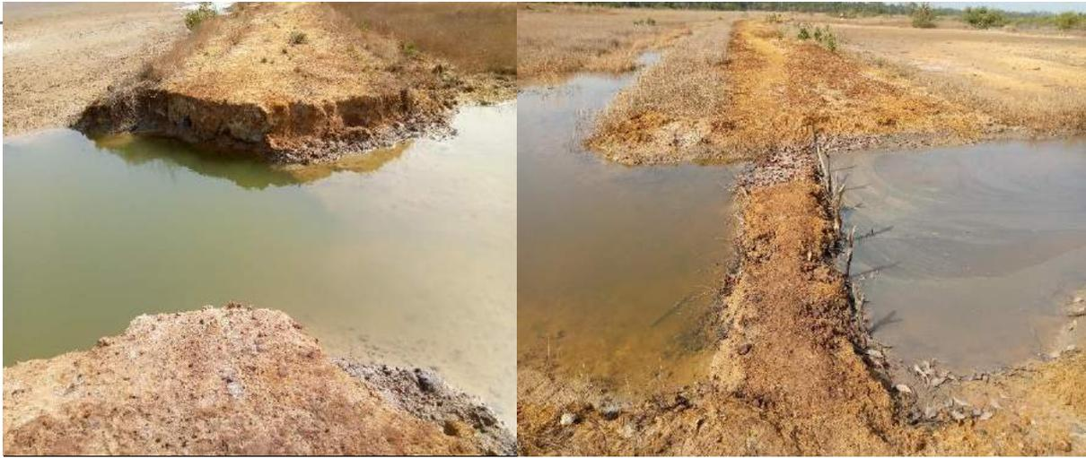
Digues réalisées en 2017 .par le programme PADERCA (digues nécessitant une reprise des travaux)
